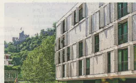
«Das Haus Merker-Park von Zulauf und Schmidlin ist ein hervorragendes Beispiel von Verdichtung», sagt Jarl Olesen.
