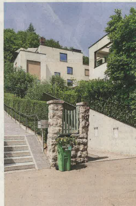
Als gutes Objekt nennt Olesen auch die Villa Pax an der Martinsbergstrasse – die beiden Neubauten wurden 2010 von den Zürcher Architekten Annette Gigon und Mike Guyer als Ersatz für eine Jugendstilvilla gebaut. Die historische Gartenmauer und der Baumbestand wurden hier erhalten. «Das war zusammen mit den eleganten Neubauten entscheidend für die Einfügung ins Quartier», erklärt Olesen.
