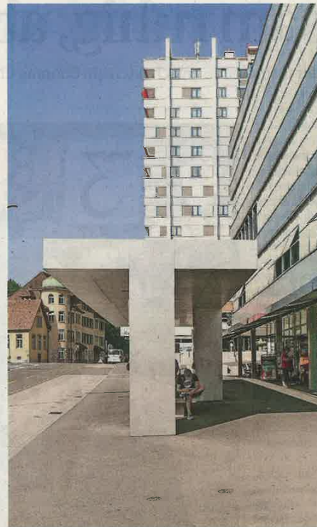
Sie fällt kaum auf: Die Bushaltestelle von Eglin Schweizer Architekten hat alles integriert in ihren Säulen – Fahrplan, Billettautomat und Abfallkübel. Die Edelstahlverkleidung nimmt die Farbgebung des Diebold-Hauses und des Hochhauses Linde auf. Links hinten das Klostertli, eines der wenigen Häuser, die von der alten Vorstadt an der Mellingstrasse noch übrig sind.
